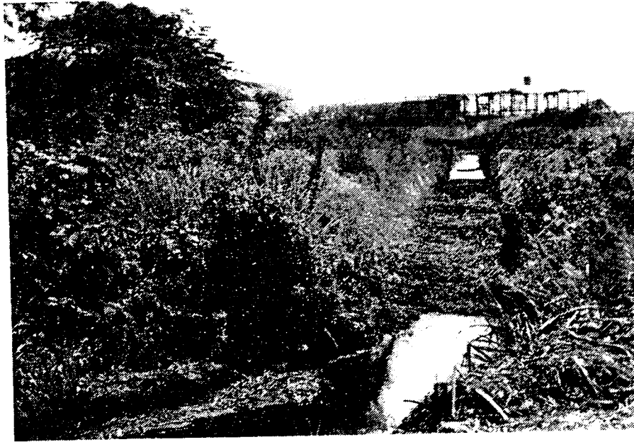
Figura 7. Escalera para peces construida en el rio Guanare, para que éstos pasen u simacio. Nótese la invasión de la vegetación y la falta de agua en los "peldaños" en una época en la cual este dispositivo debería ser funcional.
